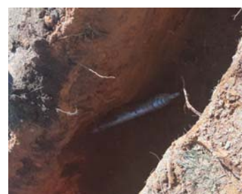
Fonçage: technique de traversée sous chaussée
